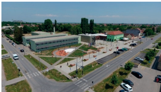
Slika 16. Zgrada Knjižnice nakon uređenja Trga 2022. godine (fotografija: Mihael Šilac)
